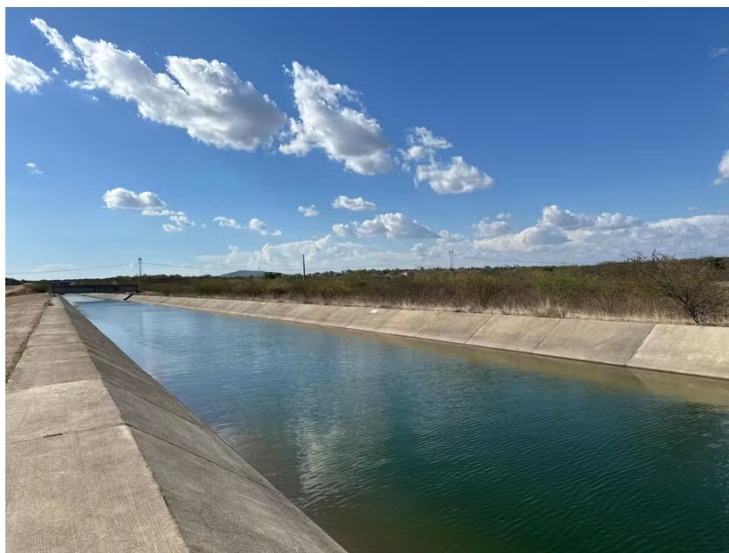
Figura 01 – Extensão do Canal do Sertão Alagoano
